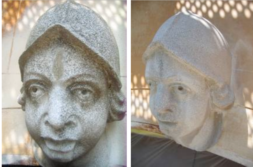
Figura 9.Figura 10: Villa Sardi particolare di mascherone in graniglia cementizia,prima e dopo l'intervento
